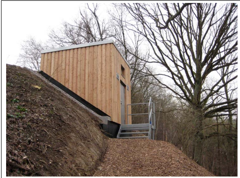
Bild 4: Außenansicht des neu gestalteten Behälterzugangs
