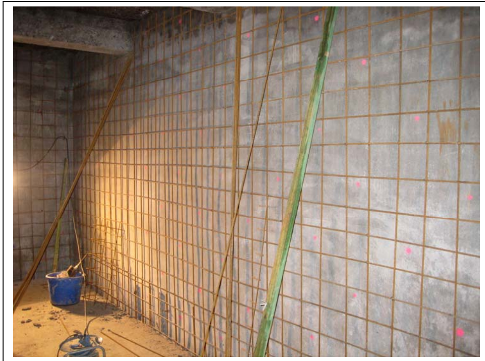
Bild 2: Bewehrungseinlage mit nachträglicher Spritzmörtelschale
