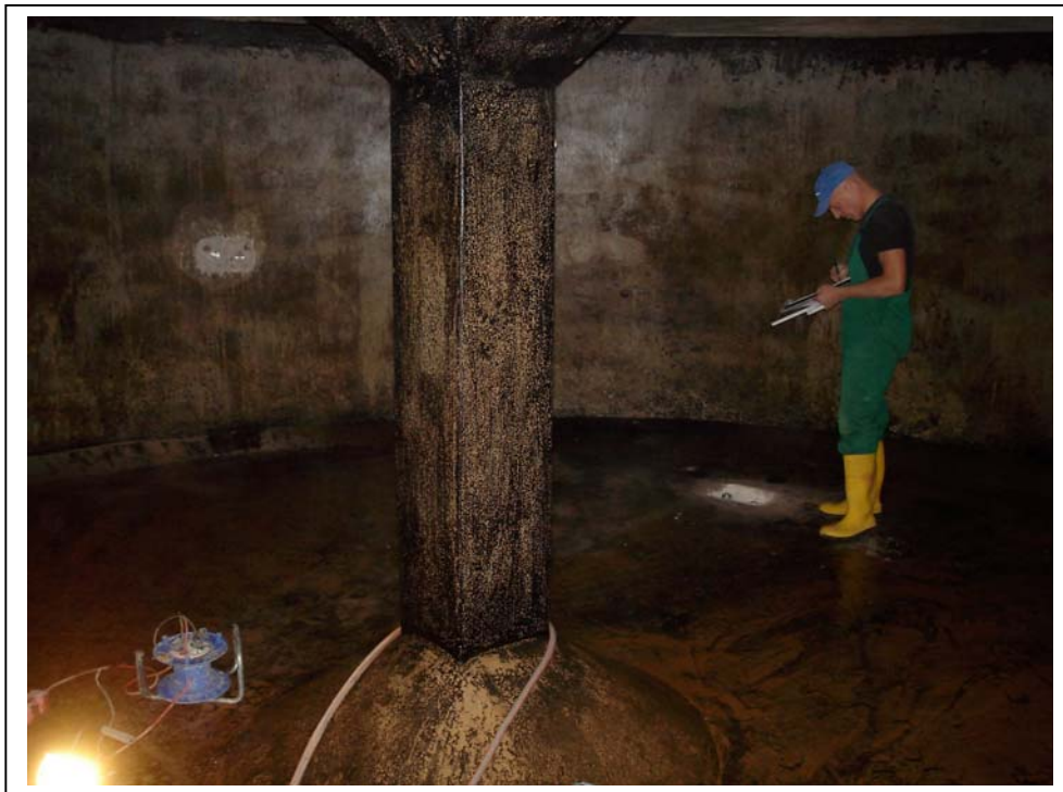
Bild 1: Durchführung der Betonvoruntersuchungen im Vorfeld der Sanierungsplanung
