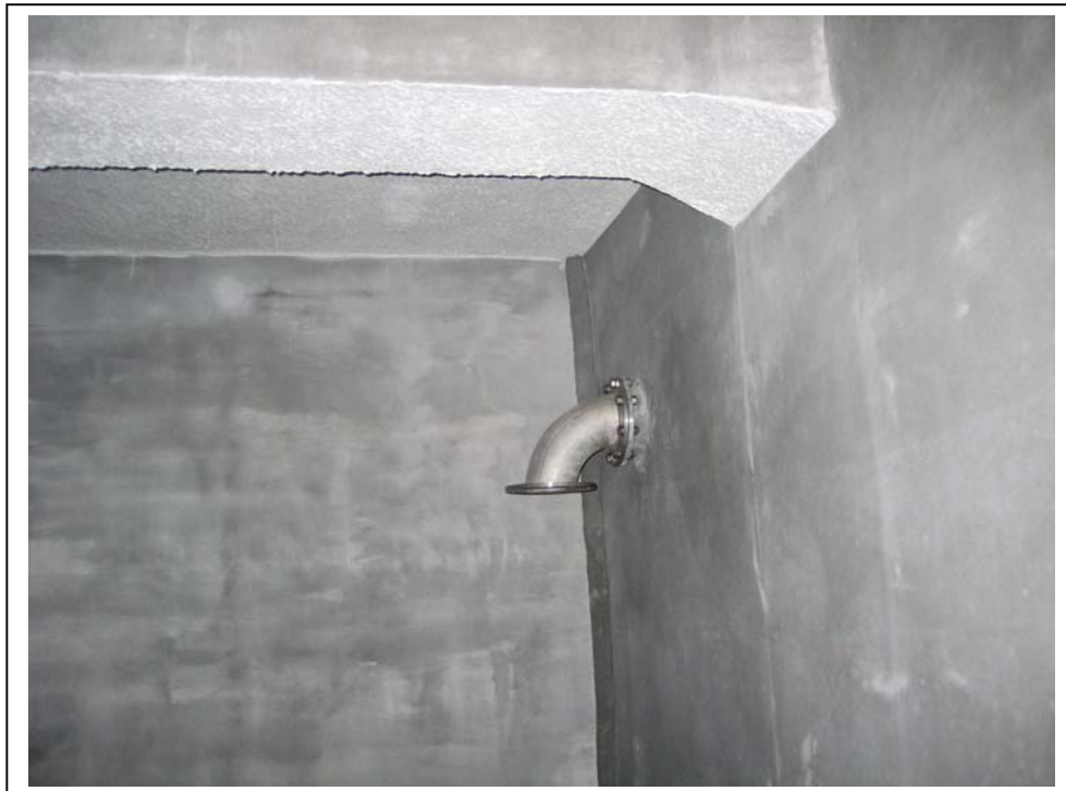
Bild 3: Fertiggestellte Wand- und Deckenbeschichtung mit Rohrdurchführung
