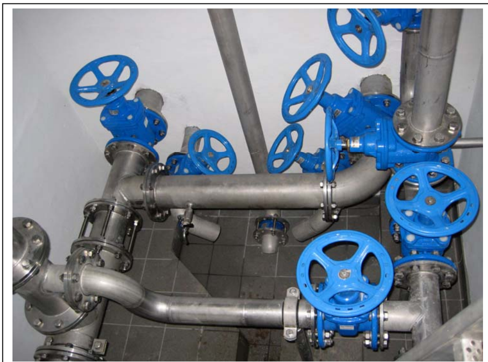
Bild 5: Neue Verrohrung in der engen Schieberkammer
