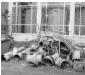
Viel Schrott: Die alten Rohre wurden komplett ausgetauscht.
