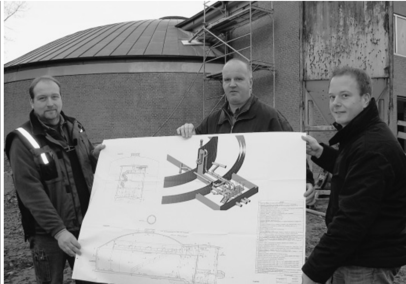
Voll im Plan: Werksleiter Reinhard Strotjohann, GUV-Geschäftsführer Martin Hobel und Baustellenleiter Jan Rassek (v.l.) von der W+S Bau-Instandsetzung freuen sich über den problemlosen Ablauf der Arbeiten bei der Sanierung des Reinwasserbehälters. FOTOS: RICHARD ZELENKA
