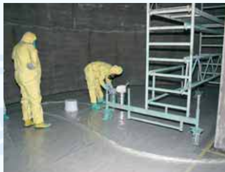
Epoxidharz wird als Beschichtung aufgetragen
